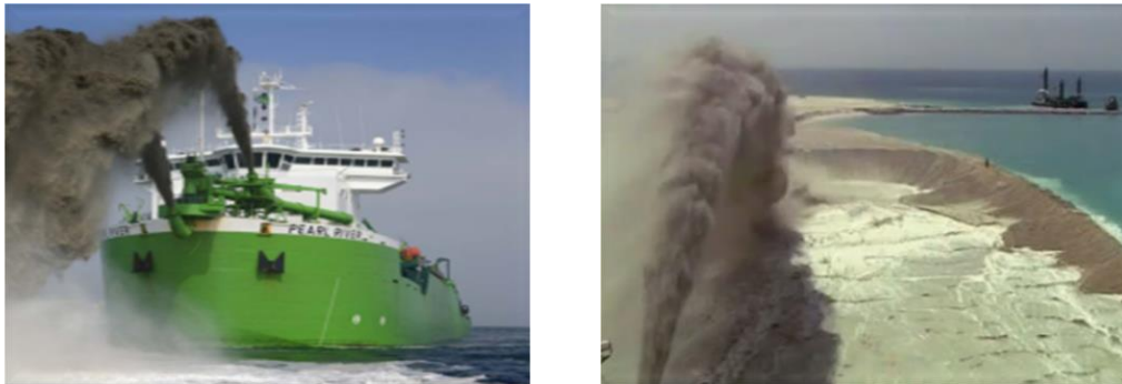
Figura 5 y 6. Ciclo de operación de dragado y vertimiento del producto del mismo.
