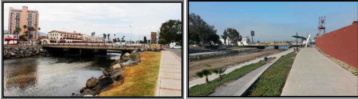
Figura 4 A la izquierda vista desde el mar y a la derecha vista hacia el mar.
