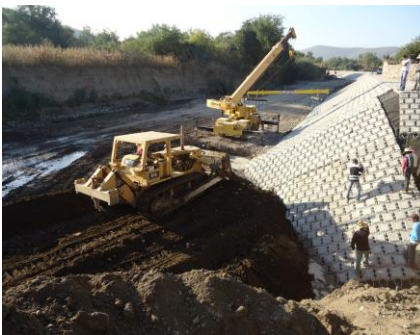
Figura 9. Unión de cuñas entre tapetes con concreto simple 250 \text{ kg/cm}^2
