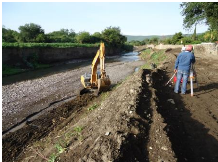
Figura 5. Trazo y nivelación.
