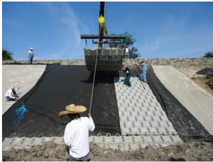
Figura 7. Colocación de tapetes en talud del terraplén.
