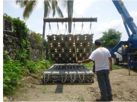
Figura 3. Tapete de concreto control de erosión en ríos. Sistema Armoflex.
