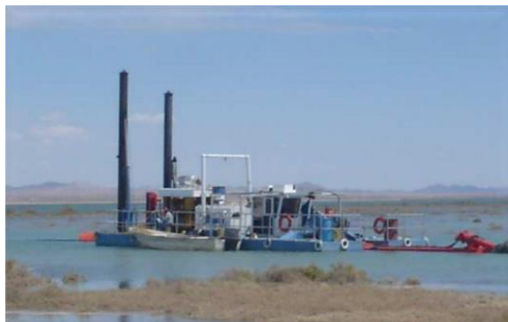
Figura 2. Trabajos de dragado
