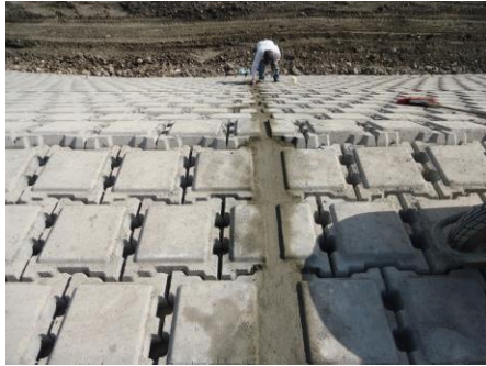
Figura 2. Tapete de concreto contra erosión de corrientes. CONTECH.
