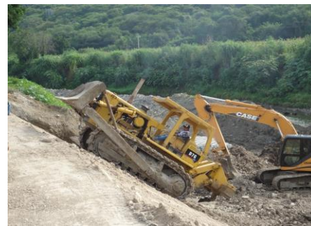
Figura 6 Compactación de bordos y terraplenes.
