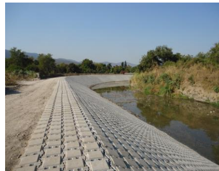
Figura 10. Panorámica obra terminada
