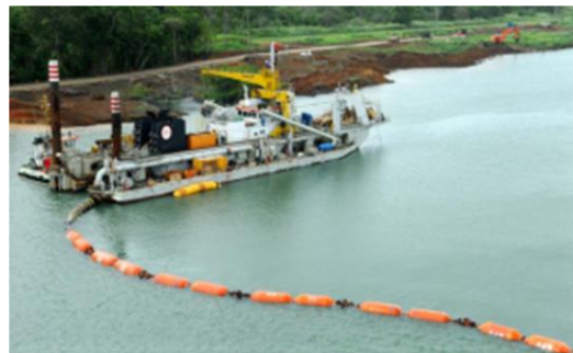
Figura 3. Tubería flotante para el vertido del material producto de dragado
